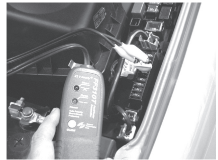
断線している配線のヒューズを外し、発信器を取り付けます。
