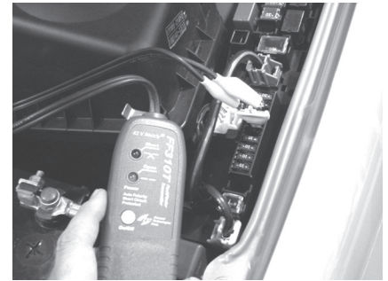
ショートしている配線のヒューズを外し、発信器を取り付けます。
